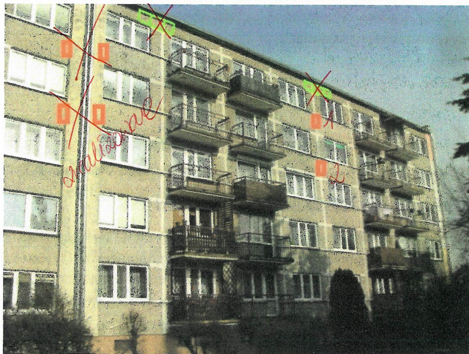
Fot. 17 i 18 Proponowany wariant rozmieszczenia skrzynek lęgowych – 12 dla wróbla i mazurka (6 na ścianie szczytowej oraz 4 na ścianie podłużnej) oraz 30 dla jerzyka – w przypadku zamknięcia otworów wentylacyjnych (24 na ścianie szczytowej oraz 6 na ścianie podłużnej)
